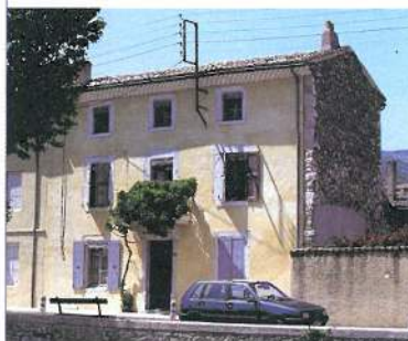
Façade quai Jules Bouvat.
