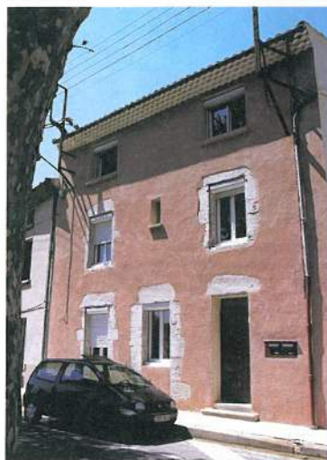
Façade quai Jules Bouvat.
